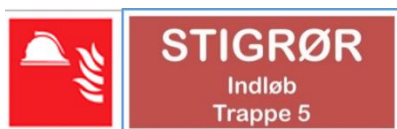
Figur ##: Eksempel på skilt til stigrør med trykforøgeranlæg
