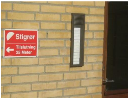
Figur ##: Henvisningsskiltning til stigrørsindløb
