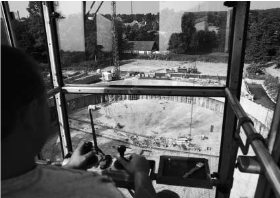
Etablering af et regnvandsbassin
