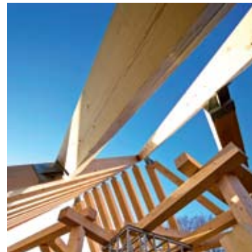
Glastaget bæres af træspær i størrelsen 45x45 centimeter.
