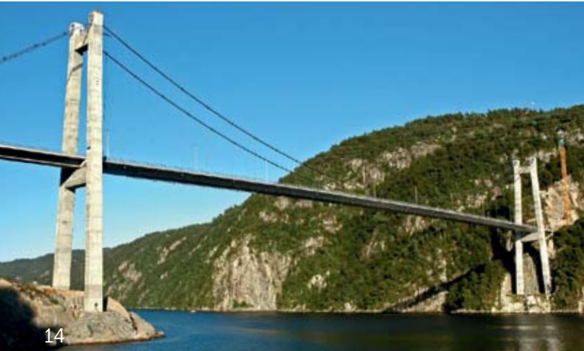
Fedafjorden bro er en hængebro over Fedafjorden i Kvinesdal kommune i Norge. Den er 572 meter lang og har et hovedspænd på 335 meter og 50 meter i frihøjde.
