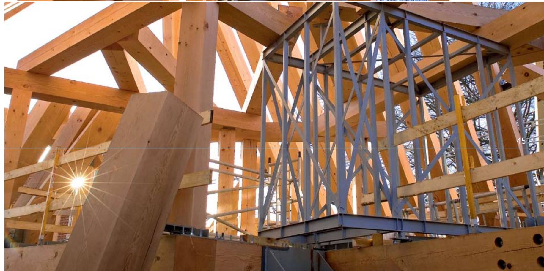
Glastaget bæres af træspær i størrelsen 45x45 centimeter.
