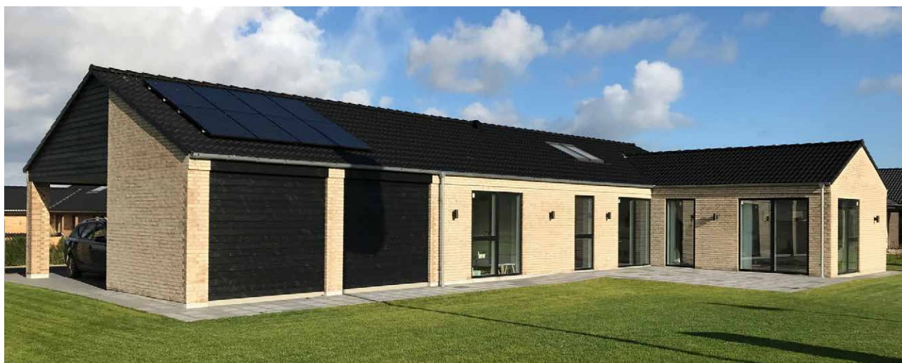
Typisk typehus opført til lavenergiklasse 2015.
